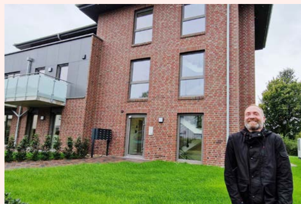
Das neue Wohnangebot an der Wiek ist das Herzensprojekt von Oliver Kuhnt. Foto: Kristin Hilbinger
